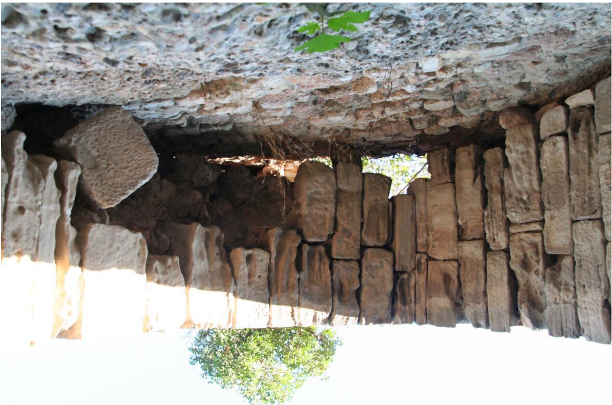
Imatge 6.-Vista de la part inferior de l'arc, on es pot observar la caiguda i desaparició d'algunes dovelles.
