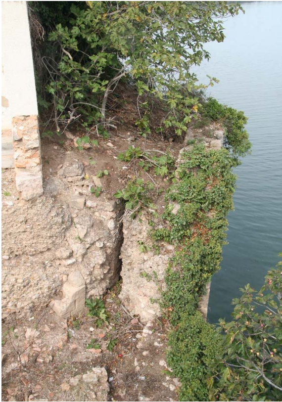
Imatges 4 i 5 .- Vista d'esquerda i desplom que afecta l'arc, i detall del seu precari assentament sobre la roca
